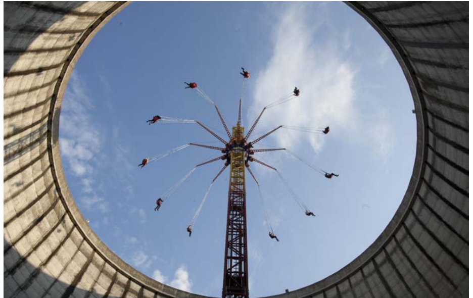
Abb. 02 | Ein Kühlturm eines Atomkraftwerks, das nie ans Netz ging, und mittendrin ein Kettenkarussell: das heutige Spielparadies «Wunderland Kalkar» (Deutschland). Der Vertical Swing vereint zwei technische Errungenschaften.
