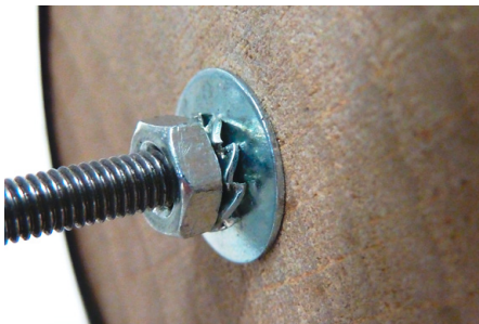
Abb. 206 | Fester Sitz auf Welle: Befestigung mit Mutter, gesichert mit Fächerscheibe
