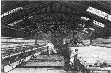
Abb. 111 | Spinnfabrik Anfang des 19. Jahrhunderts
