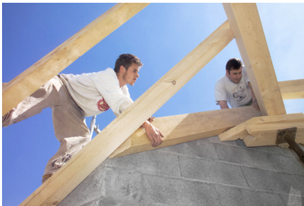
Abb. 96 | Ein Zimmermann bei der Arbeit
