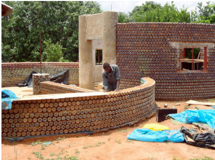
Abb. 25 | Ein Haus entsteht aus mit Sand gefüllten PET-Flaschen.
