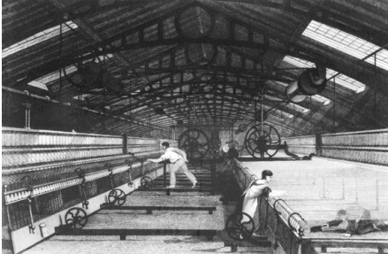
Abb. 111 | Spinnfabrik Anfang des 19. Jahrhunderts
