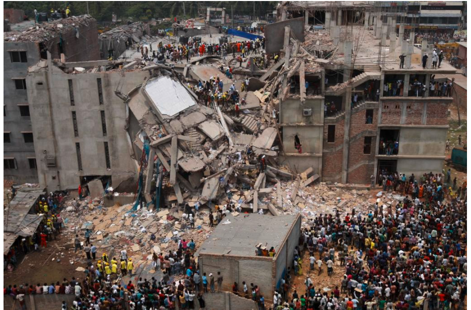
Abb. 05 | Am 24. April 2013 stürzte ein Fabrikgebäude in Sabhar in Bangladesch ein. Über 1000 Menschen kamen ums Leben.
